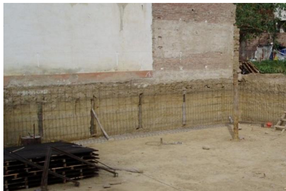
Figura 1 – Excavación del terreno
