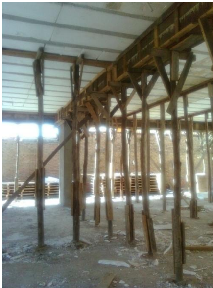
Figura 3 - Encofrado de la losa
