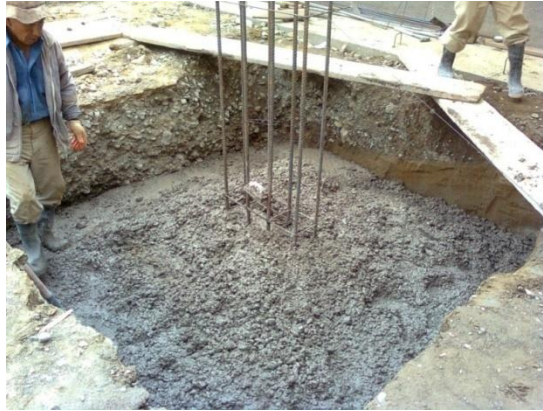
Figura 2 - Vaciado de una zapata
